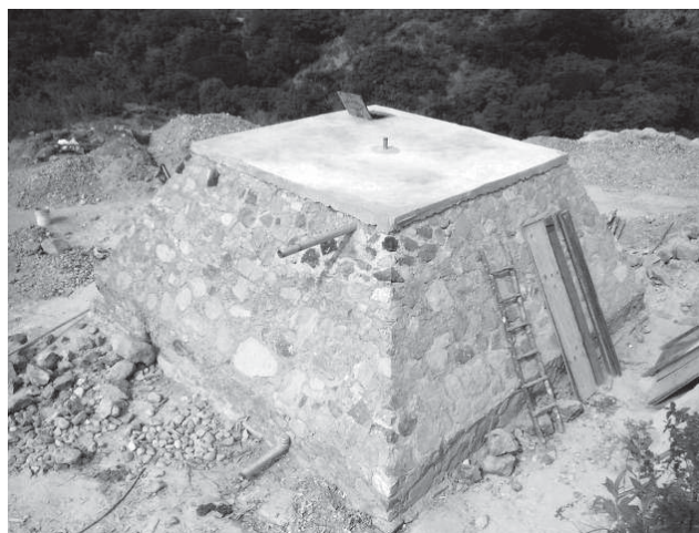
Obra realizada en la localidad Desmoronado, Talpa de Allende.
