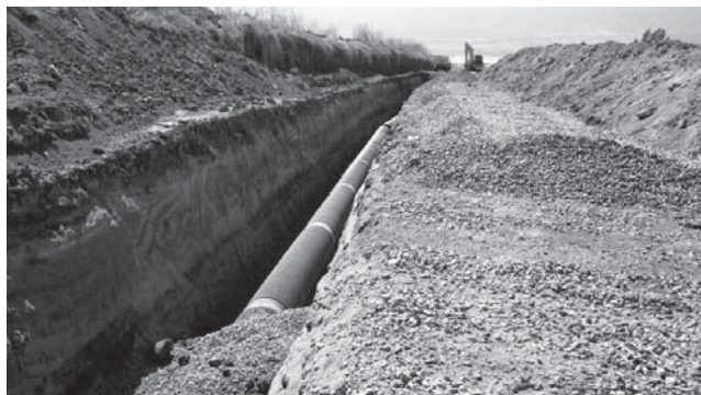
Instalación del Colector.
