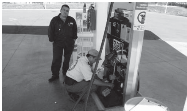
Inspección de valores de explosividad en instalaciones de estaciones de servicio.
