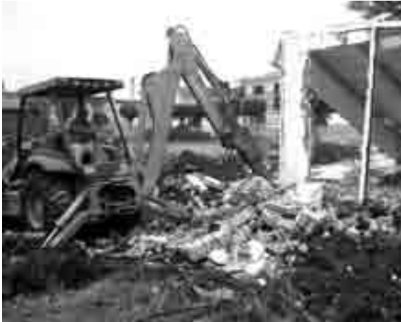
Demolición del Centro de Salud
