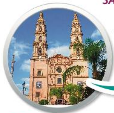
CATEDRAL BASÍLICA "SANTUARIO DE LA VIRGEN DE SAN JUAN DE LOS LAGOS" CONSTRUCCIÓN DEL SIGLO XVIII
