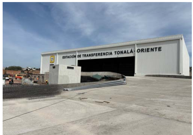
Ilustración 22. Construcción de la Estación de Transferencia Oriente.
